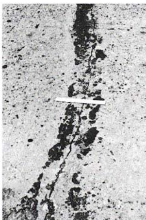
Figura C-8.a. Agrietamiento Lineal Baja-severidad.
