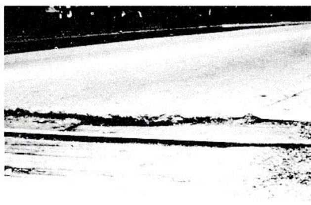
Figura C-15.c. Cruce de Ferrocarril Alta-severidad.
