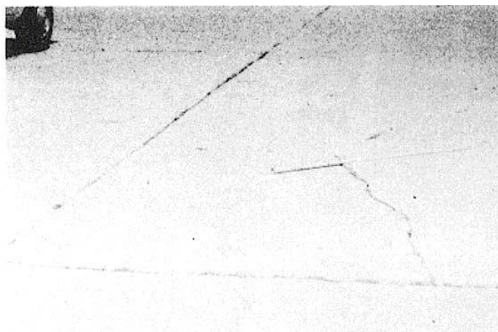
Figura C-2.b. Ruptura de Esquina Media-severidad.
