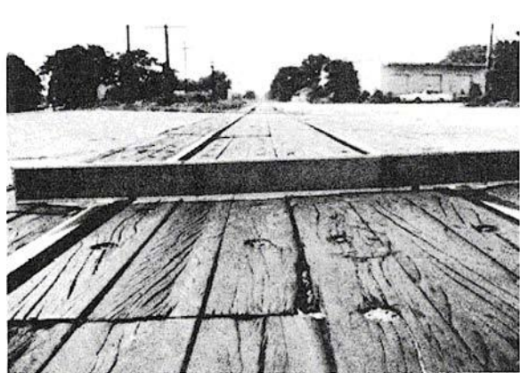
Figura B-14.a. Cruce de Ferrocarril Baja-severidad.
