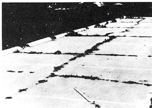
Figura C-3.b. Losa Dividida Media-severidad.
