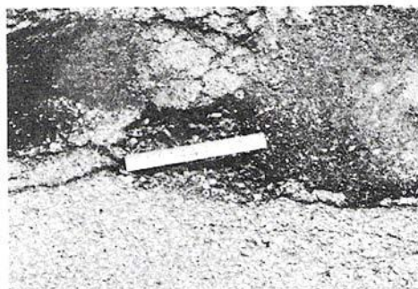
Figura B-13.a. Baches Baja-severidad.
