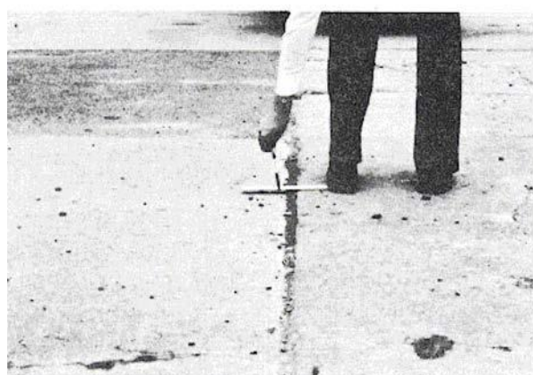
Figura C-5.b. Falla Media-severidad.
