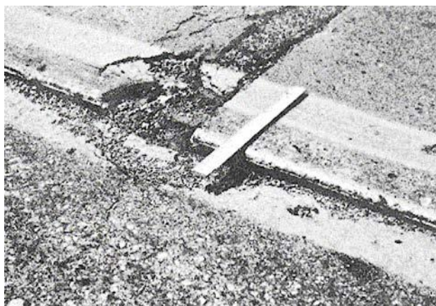
Figura C-7.a. Caída Externa de Vía / Hombreira Baja-severidad.
