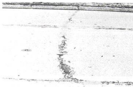
Figura C-8.c. Agrietamiento Lineal Alta-severidad.
