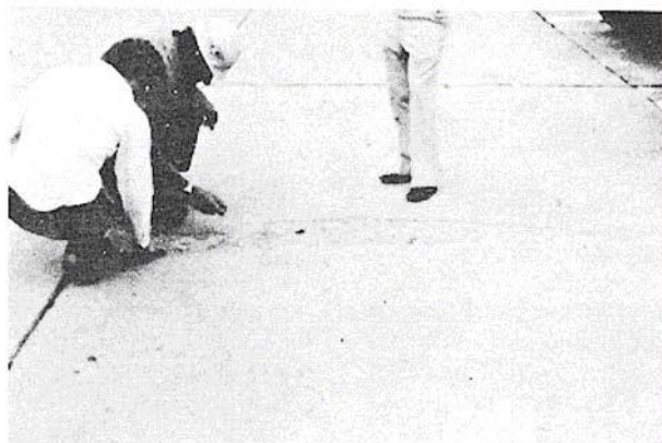
Figura C-4.b. Agrietamiento (“D”) de Durabilidad Media-severidad.
