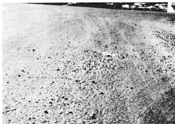
Figura B-19.b. Intemperismo Media-severidad.
