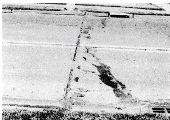
Figura C-14.b. Punzonamiento Media-severidad.
