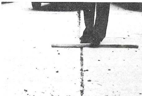
Figura C-5.a. Falla Baja-severidad.
