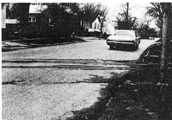
Figura B-14.c. Cruce de Ferrocarril Alta-severidad.
