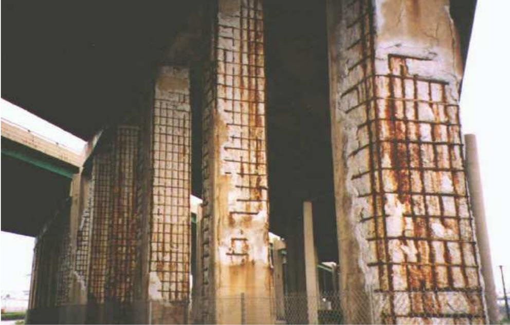
Fig. 5.34. Corrosión del acero en pilotes de un puerto.
